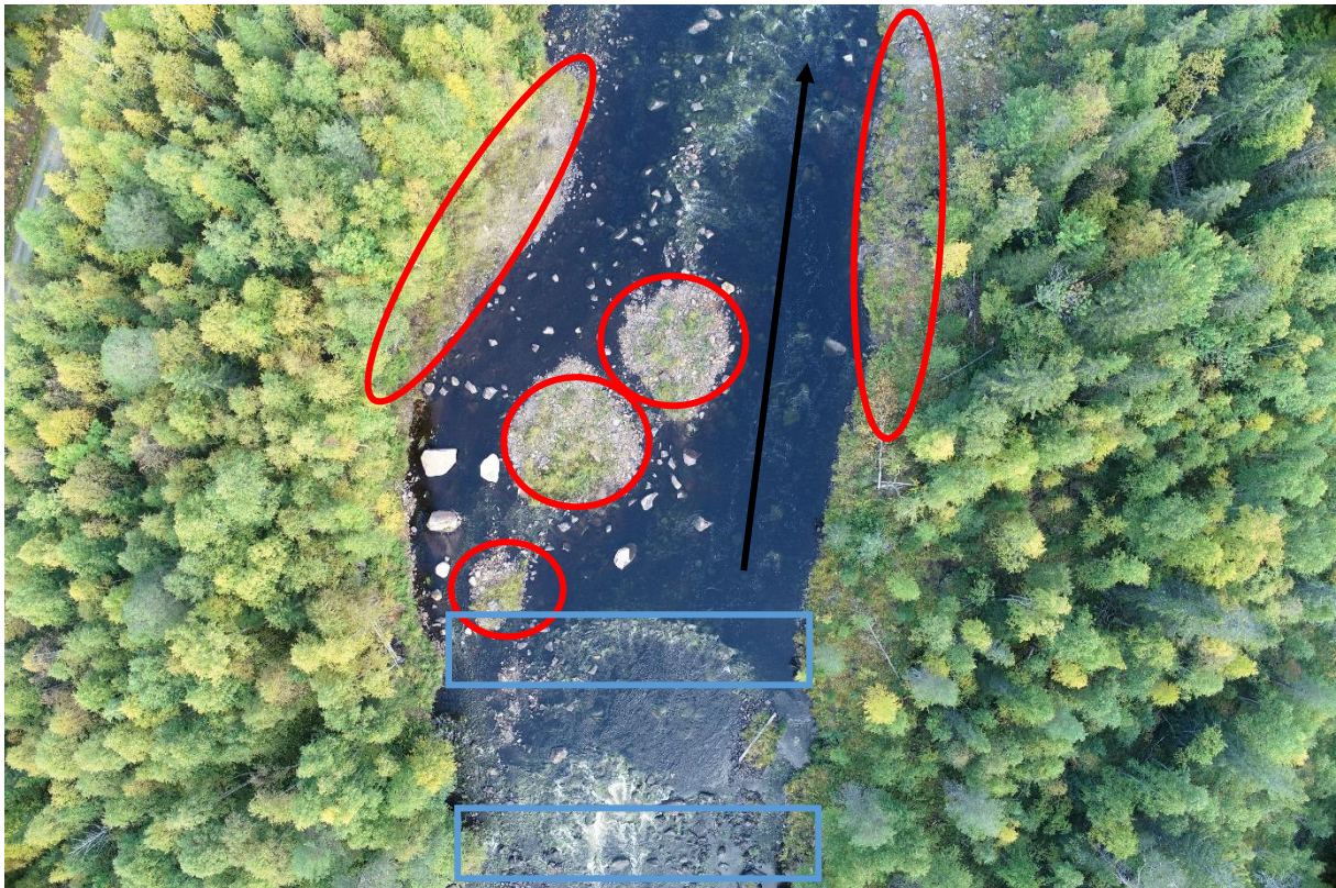
Figur 48. Drönarflygning den 12/9 2022. Röd ring = strandvegetation som tillskapats. Svart polygon = kulturobjekt stenmur som rivits ut. Blå polygon = tröskel som rivits ut. Helt dragen svart pil markerar huvudfåra.
