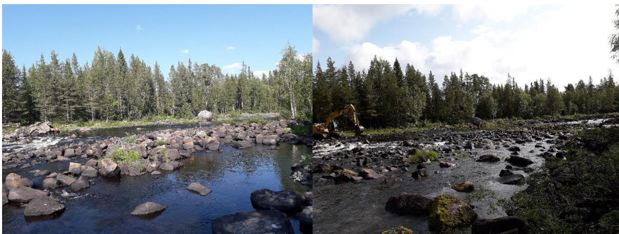
Figur 42. Stenbalk före (vänster panel) och efter (höger) restaurering.
