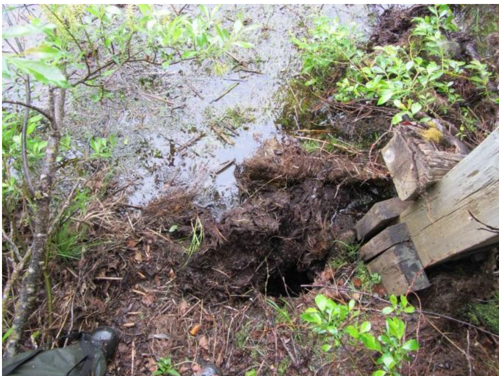
Figur 57. Munk och trumma före rensning och slutlig utrivning. Foto: Sofi Lundbäck
