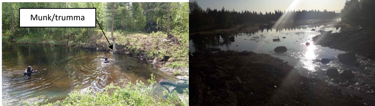
Figur 59. Vänster panel. Dykare som röjer området vid munken/trumman. Höger panel: Tröskel till Lickotgrenen 2019 efter utrivning av trumma och munk. Foto: vänster panel, Umeälvens vattenregleringsföretag. Höger panel, Greger Jonsson.
