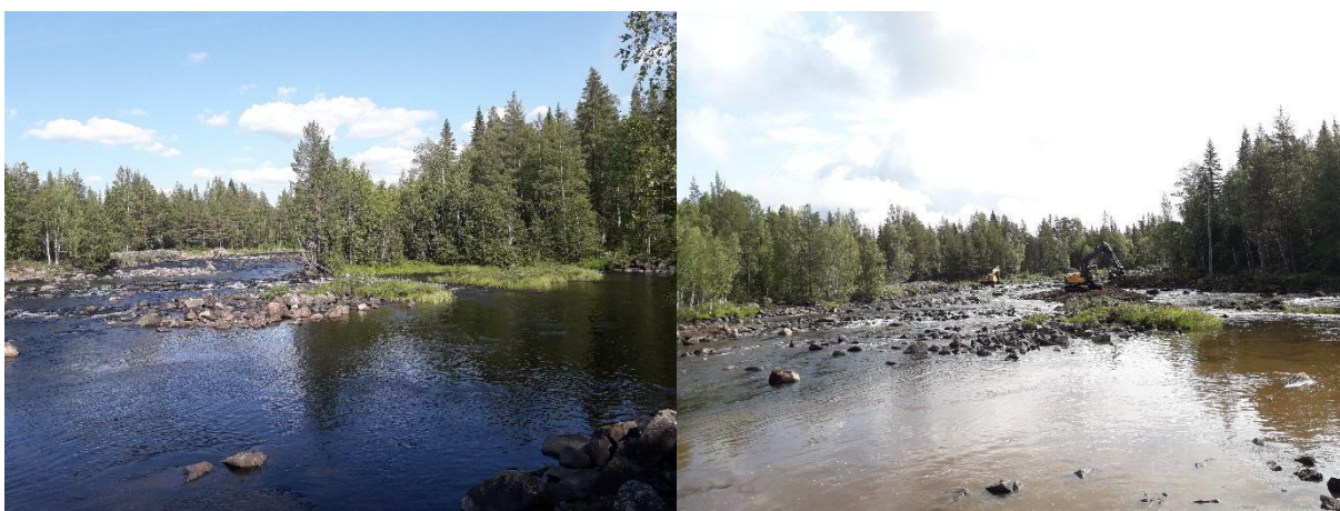
Figur 43. Utrivning av stenbalk före uppströms starrbält (vänster) och efter (höger) restaurering med skapande av öar och kvillområden.
