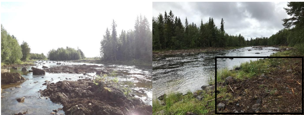
Figur 46. Stränder som släntats av. Vänster: direkt efter restaurering. Höger: Efter ett år. Svart polygon markerar lokal för utriven flottledsrensning.
