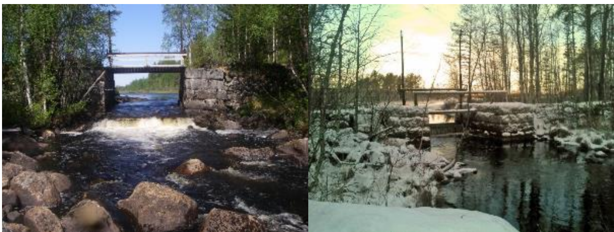
Figur 80. Vänster: Övre Gattjaurdammen. Höger: Jåkarndammen (2013-10-31)
