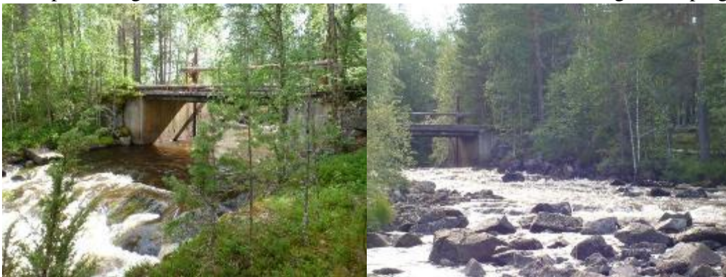
Figur 138. Foto vänster och höger. Damm vid utlopp av sjön Rusträsket.
