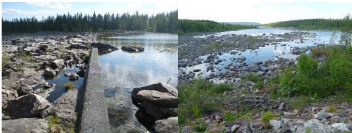
Figur: Vänster: i torrån är det byggt spgeldammar för att hålla upp vattennivåer och skapa bassänger. Höger: torrån sedd från väg E45.
