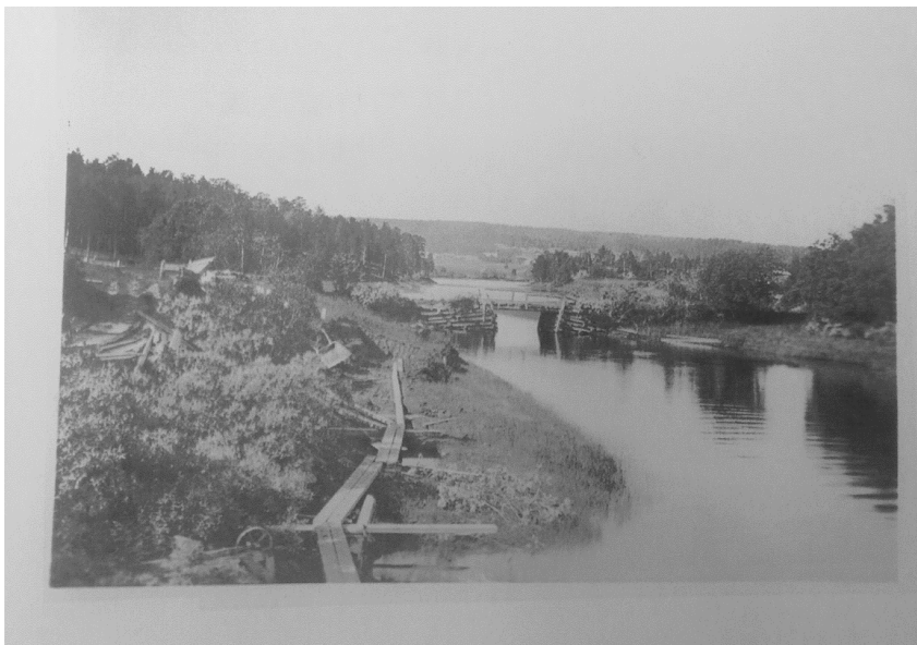
Figur 4. Bodbäckens mynning före byggnation av vallar och pumpstation
