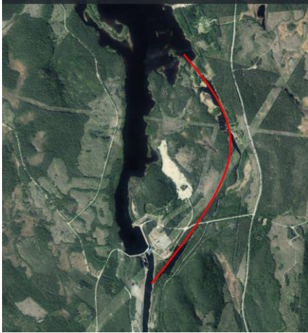
Figur 50. Ortofoto över sidofåran runt Tuggen kraftverk, Eniro.se.
