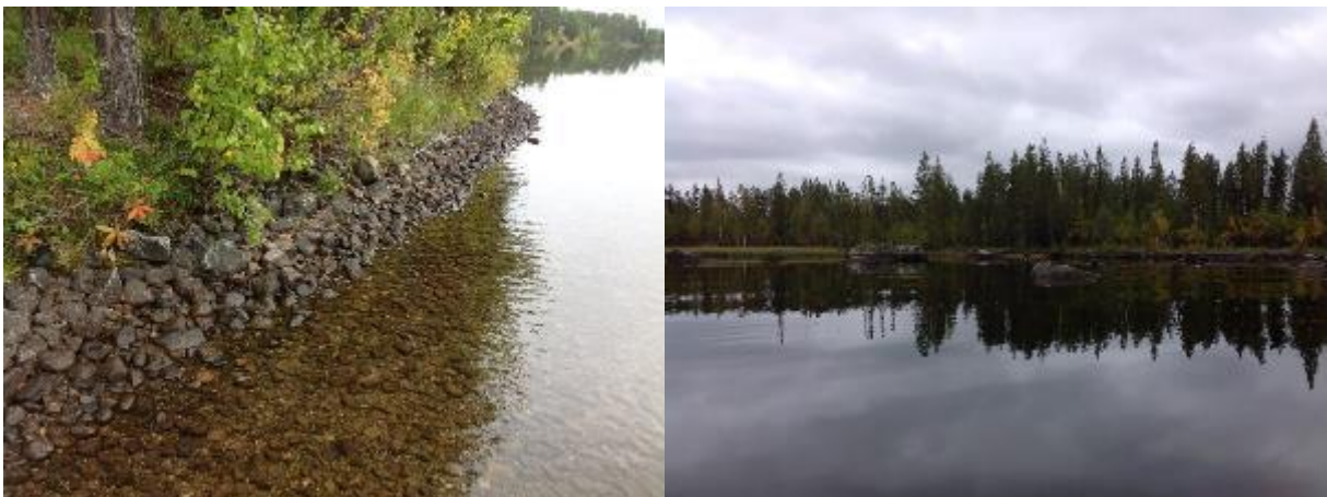
Figur: Vänster: Eroderad strand. Höger: Strand med block som skyddar
