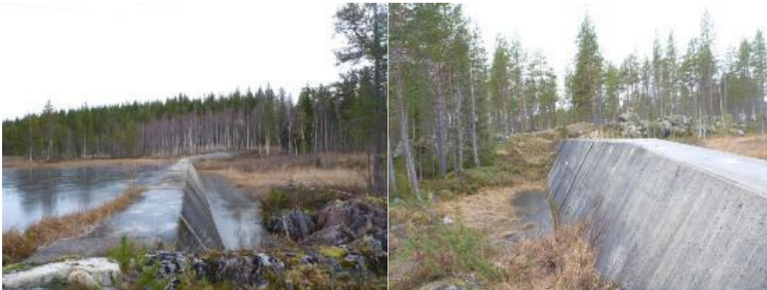
Figur 53. Grunddamm Tuggensele kraftverk (betongbarriär)
