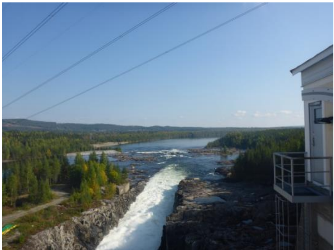
Figur 161. Grundforsens kraftverk, vy från bron över kraftverket vid släpp genom luckorna.
