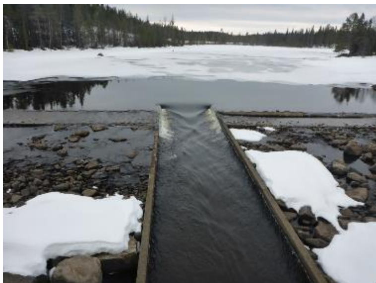
Figur 196. Dammen i Nedre Lomfors och den fiskväg som finns vid dammen.
